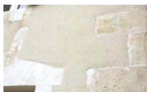
La mise en œuvre de l'enduit, affleurant les pierres d'encadrement et de chaînage : le mortier doit affleurer la surface extérieure des pierres, sans être en surépaisseur.
