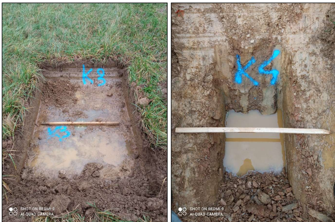
Photographies du sondage PK3 (à gauche) et PK4 (à droite)
