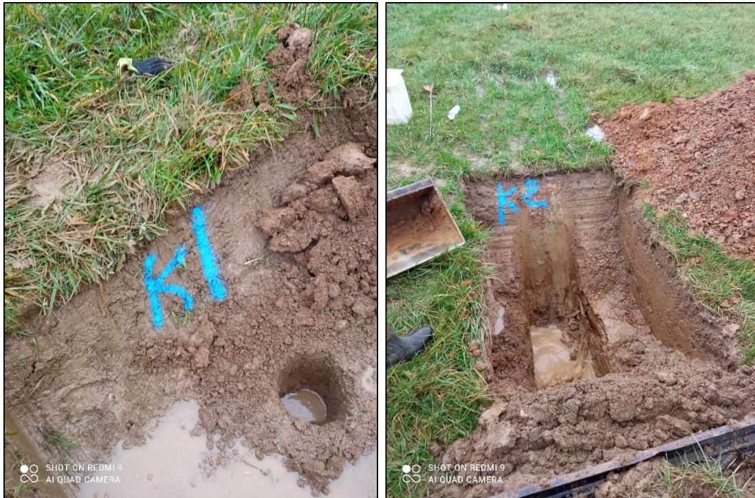
Photographies du sondage PK1 (à gauche) et PK2 (à droite)
