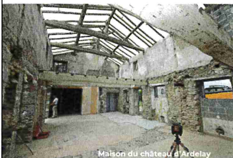
Maison du château d'Ardelay
