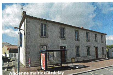
Ancienne mairie d'Ardelay
