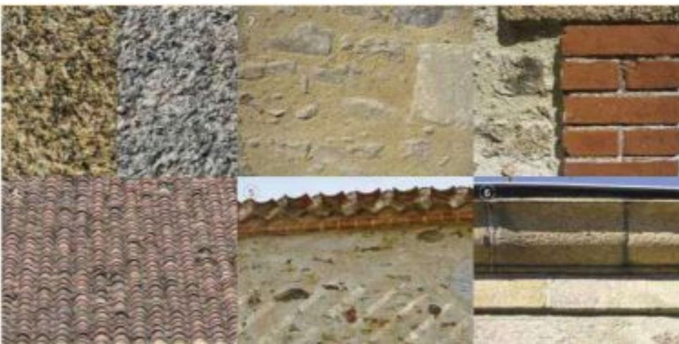
*Granites, enduit à la chaux sur mur en pierre, brique, tuile tige de botte, génoise, corniche en granite.
